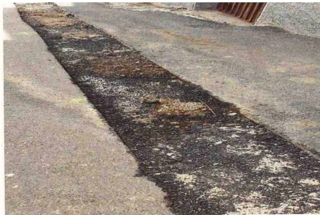
Estado original del tramo a renovar en el cual ya se había realizado el corte del pavimento.
