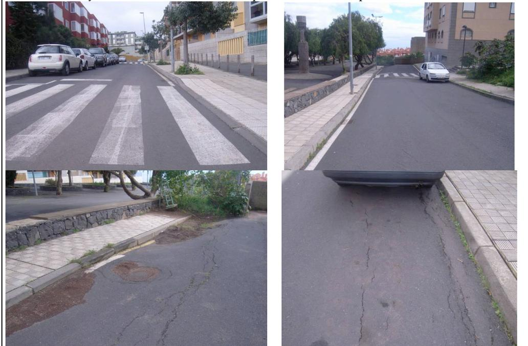
Deformación en aceras con asentamiento de bordillos a distinto nivel:
